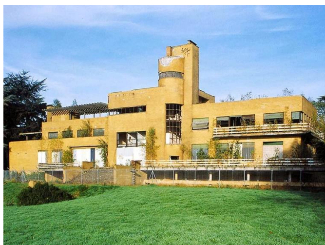
01. La villa Cavrois avant le début des travaux de restauration en 2003.
