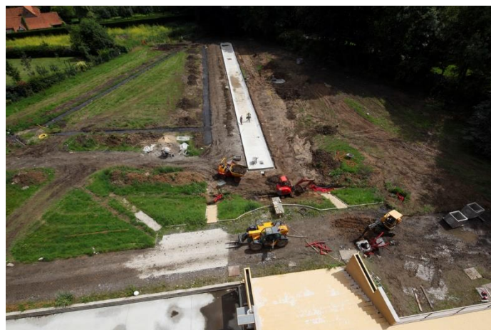
06. Vue du jardin et du miroir d'eau depuis le 1 er étage en 2012
