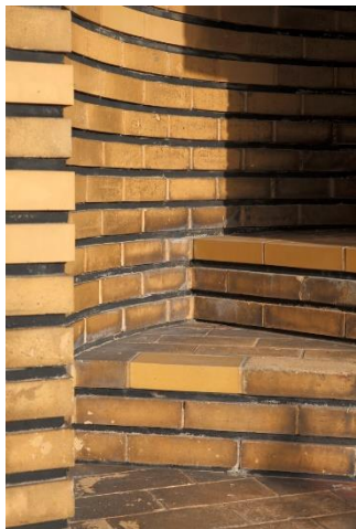
05. Détail d'une marche montrant une brique neuve, escalier d'accès à la salle à manger des enfants, après restauration en 2014
