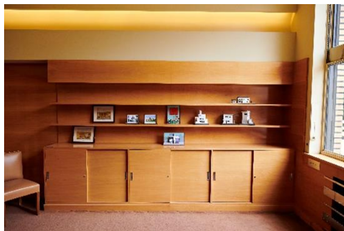
15. Éclairage indirect dans le bureau
